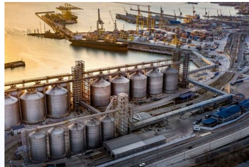
3-я очередь расширения Новороссийского зернового терминала Заказчик: ООО «КПТП»
